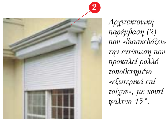
Ρολλό εξωτερικό επί κουφώματος με κουτί φάλιτσο 45°
