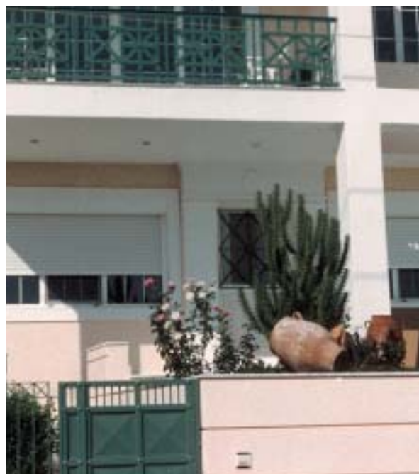
Ρολλό εξωτερικό επί κουφώματος με κουτί φάλιτσο 45°
